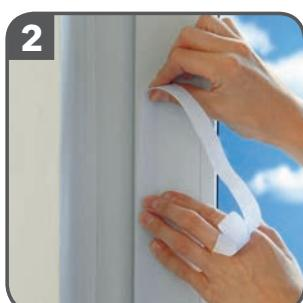
Coller les bandes auto-agrippantes (**côté B**) au choix sur le côté **a)** extérieur ou **b)** intérieur de la fenêtre (côté poignée). Veiller à ce que la fenêtre puisse se fermer.
