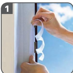
Fenster zuerst öffnen und die zu beklebenden Flächen auf dem Fensterrahmen und -flügel reinigen, so dass sie frei von Staub und Fett sind. Klettverschluss öffnen und das Klettband (**Seite A**) auf den Fensterrahmen kleben.
