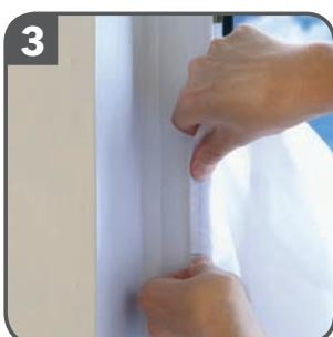
Erst die breite **Seite A** (Reißverschluss bleibt geschlossen) bei geöffnetem Fenster von der Mitte weg nach links und rechts, bzw. nach oben und unten komplett am Fensterrahmen ankleben.
