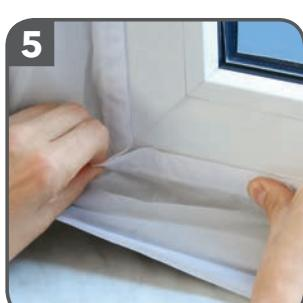
Fixer le côté le plus étroit **B** (fermeture éclair fermée) sur le battant de fenêtre en partant du centre vers les côtés droit et gauche et vers le haut et le bas.
